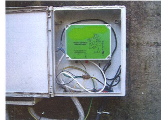
fig.3 - posizionamento di un alimentatore in un quadro elettrico
