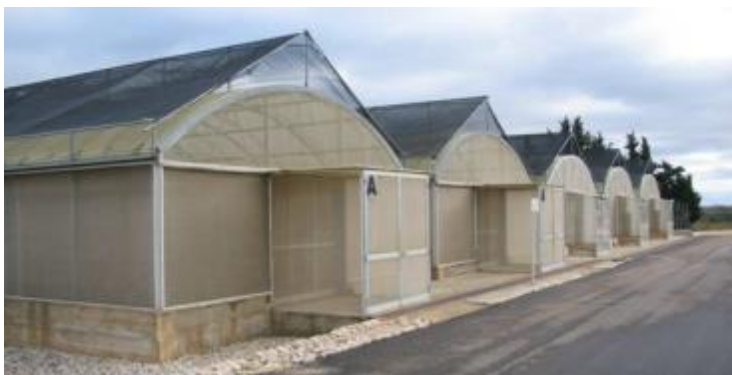
Screen House (serre a doppia rete a prova d'insetto per il completo isolamento dall'ambiente circostante e la conservazione in condizioni di sanità)
