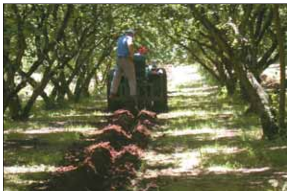
Fig. 2 Irrigazione del nocciolo: impianto di sub-irrigazione, durante (sopra) e dopo la messa in posa (sotto).
